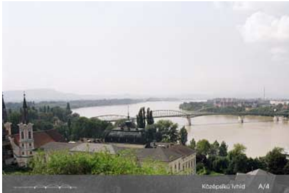
4. kép: A középső, egy kábelsíkos ívhíd
