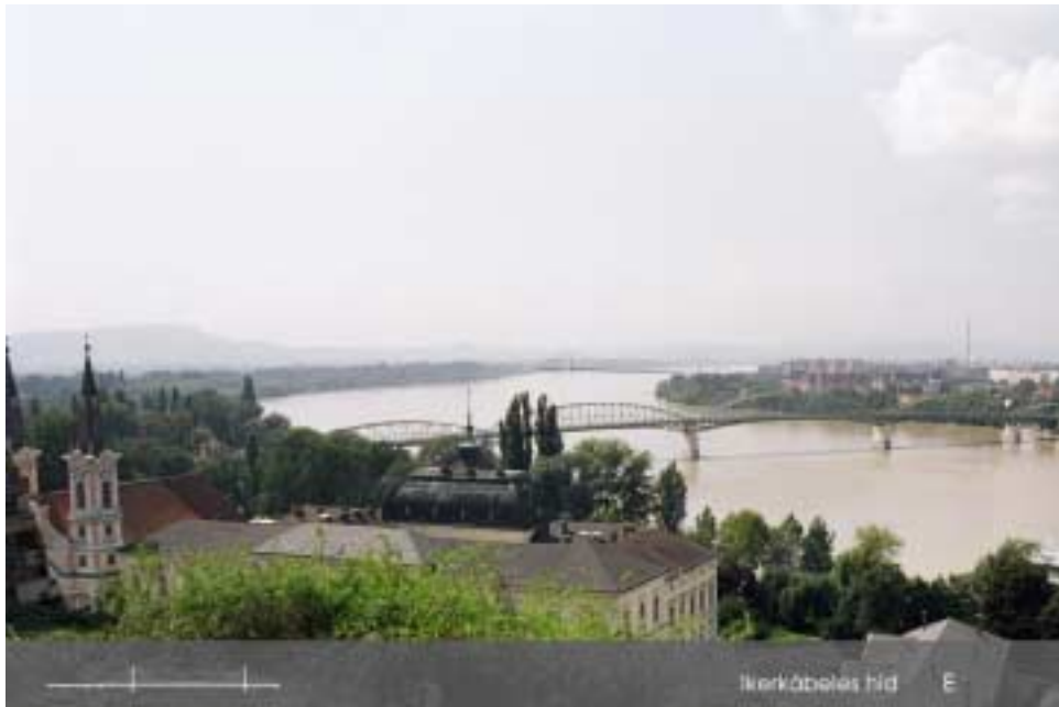
10. kép: Középső kábelsíkú, ikerkábeles függőhíd
